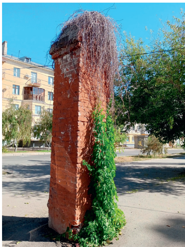
Рис. 6. Озеленение юго-западного фасада кирпичного столба в г. Волгограде. По классификации Коррен тип климата – Dfa
