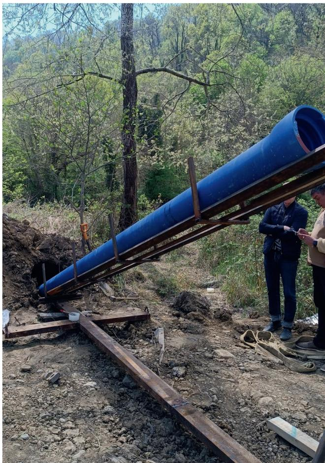
проходил под рекой Кудепста и позволял осуществить вход в грунт только под углом наклона в 45°. Сложная задача обусловила выбор метода прокладки и материала труб: заказчик применил безтраншейные технологии – метод горизонтально направленного бурения и трубы из ВЧШГ с раструбно-замковым типом соединения.
