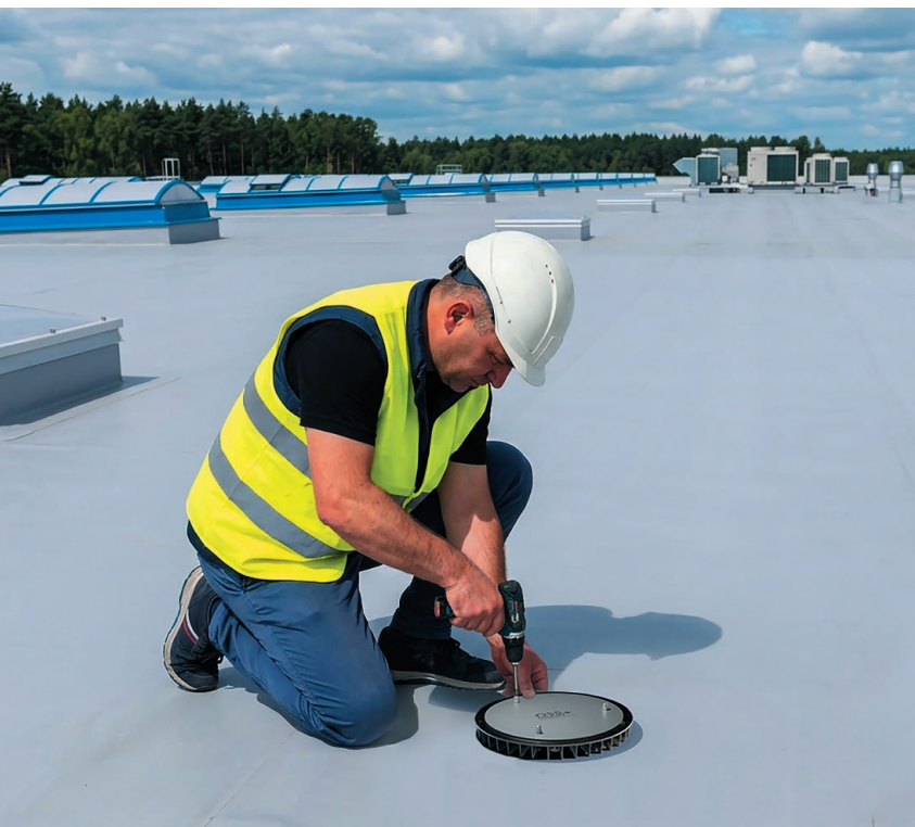
Монтаж воронки QSS+ DRAIN
