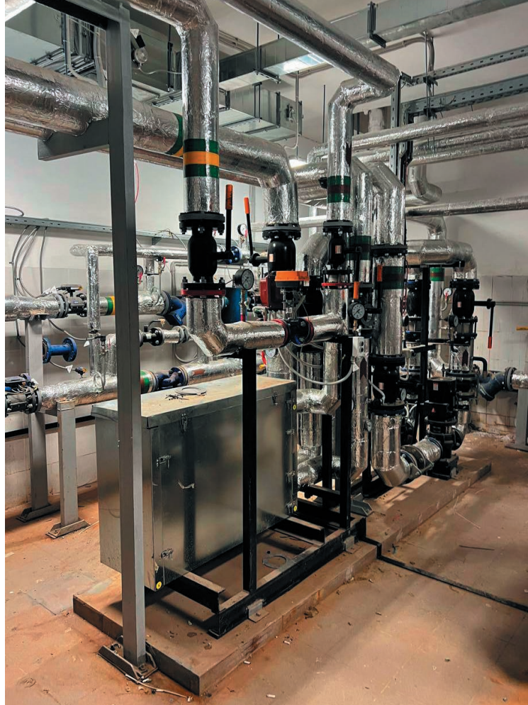
БИТП, установленный на объекте
