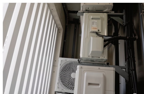
Рис. 3. Пример плана с техническим балконом, закрытым декоративной решеткой
