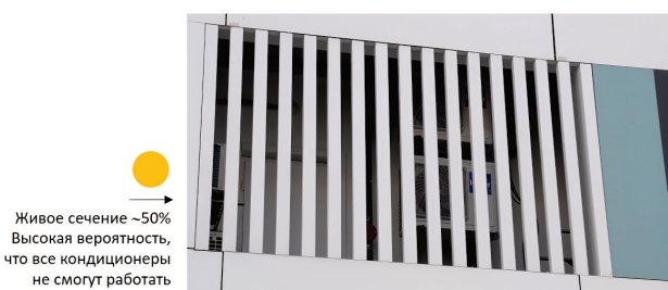
■ Рис. 10. Четыре примера ограждения технических балконов
