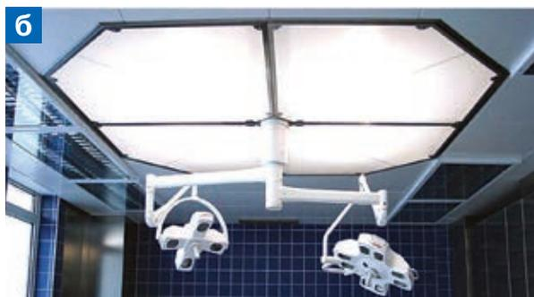
Рис. 1. Примеры прямоугольного (а) и восьмиугольного (б) исполнения операционного потолка однонаправленного (ламинарного) потока
