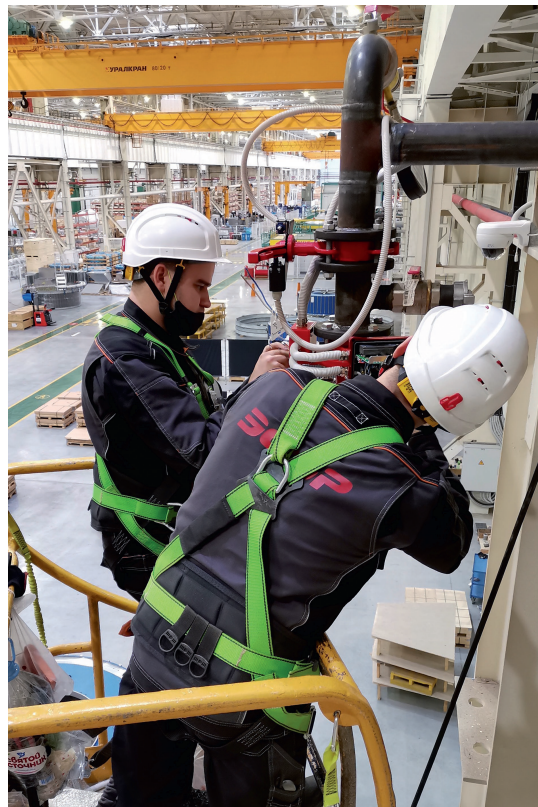
Монтажные и пусконаладочные работы на объекте
