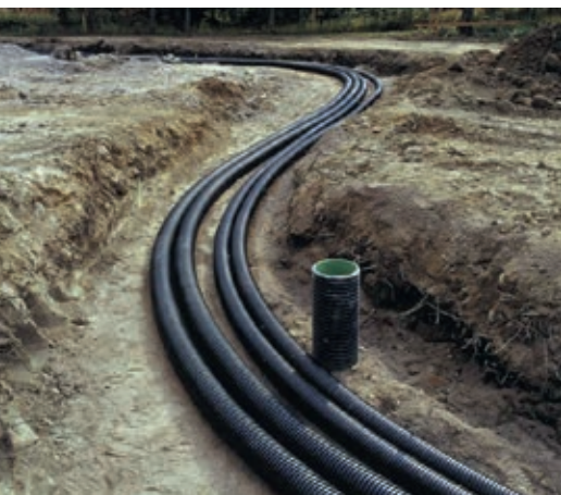
■ Бесканальная прокладка полимерных теплотрасс
