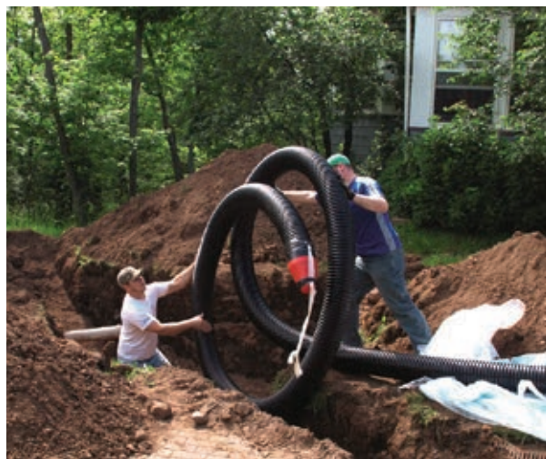
■ Процесс монтажа полимерных теплотрасс без специальной техники
