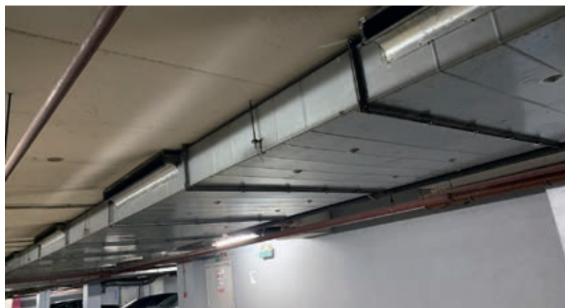
■ Воздуховод 2000×200, обнаруженный на одной из европейских стоянок
