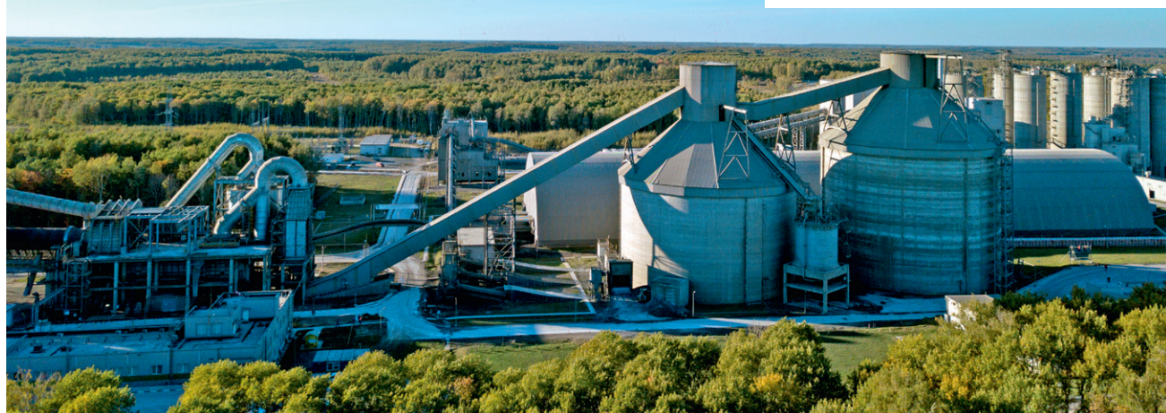
Ферзиковский цементный завод ЛафаржХолсим Россия
