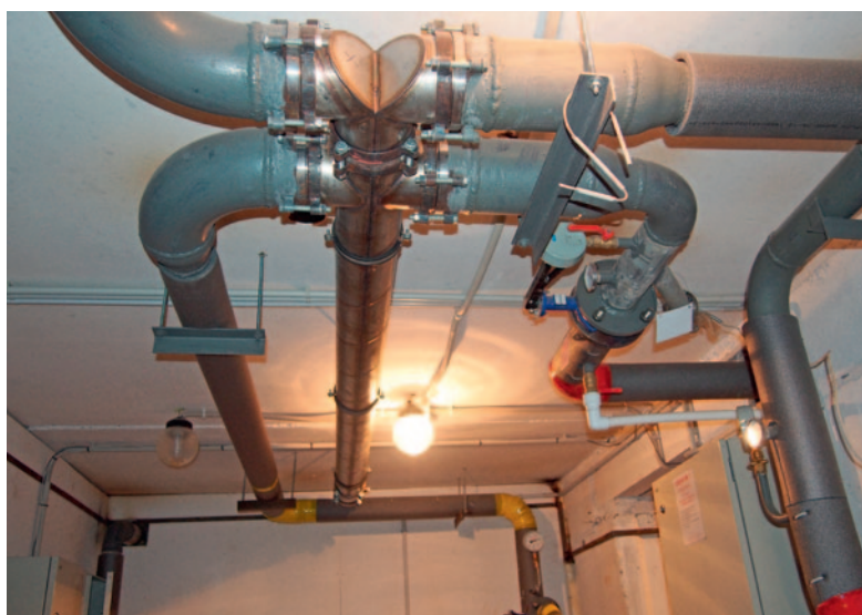
Рис. 3. Теплообменник ТТАИ под потолком подвала жилого здания
