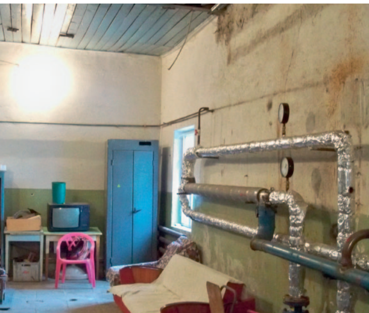
Рис. 4. Высвободившееся помещение прежнего теплопункта
