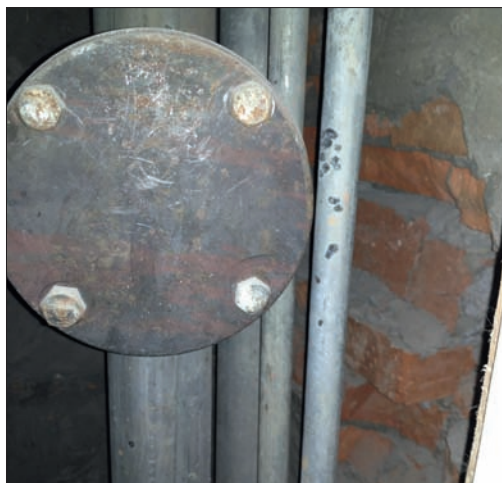
Рис.4. Неизолированные стояки в шахте
