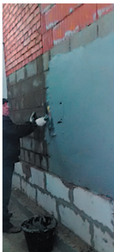
Рис. 1. Процесс монтажа фрагментов ограждающих конструкций в климатической камере
