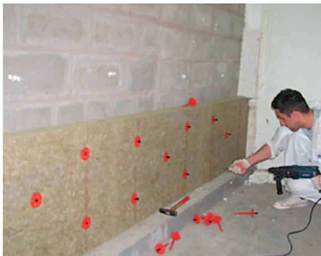
Рис. 1. Процесс монтажа фрагментов ограждающих конструкций в климатической камере
