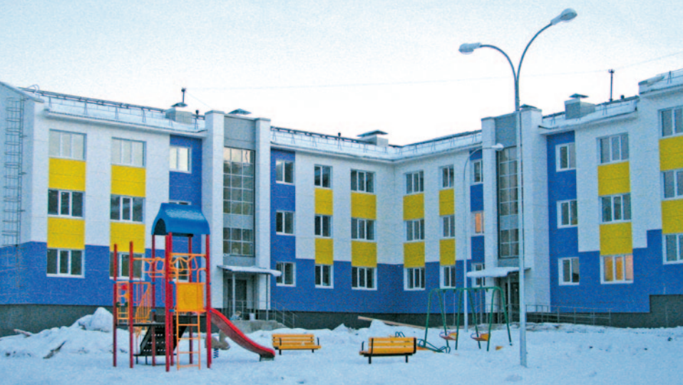
Энергоэффективный многоквартирный дом в Мурманской области
